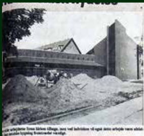
Den gamle kirke i Husum, som var i færd med at blive nedrevet, og den nye kirke i baggrunden.
